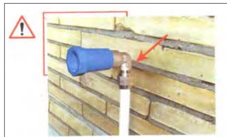
تصویر ۴: صفحه‌ی نصب مخصوص (شابلون) محل نصب رادیاتور در شبکه‌ی لوله‌کشی
