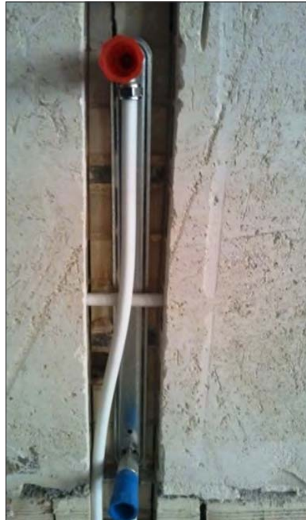
تصویر ۴: صفحه‌ی نصب مخصوص (شابلون) محل نصب رادیاتور در شبکه‌ی لوله‌کشی
